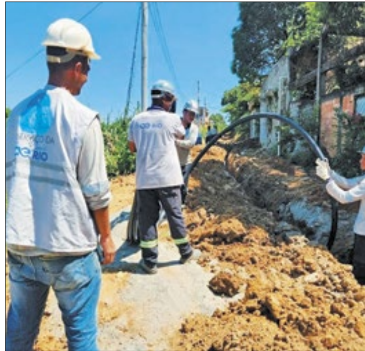
Águas do Rio promove melhorias em Engenheiro Pedreira
