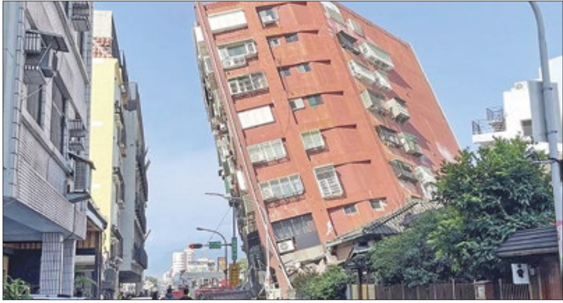
Tremores fizeram prédios desabarem e causaram deslizamentos
