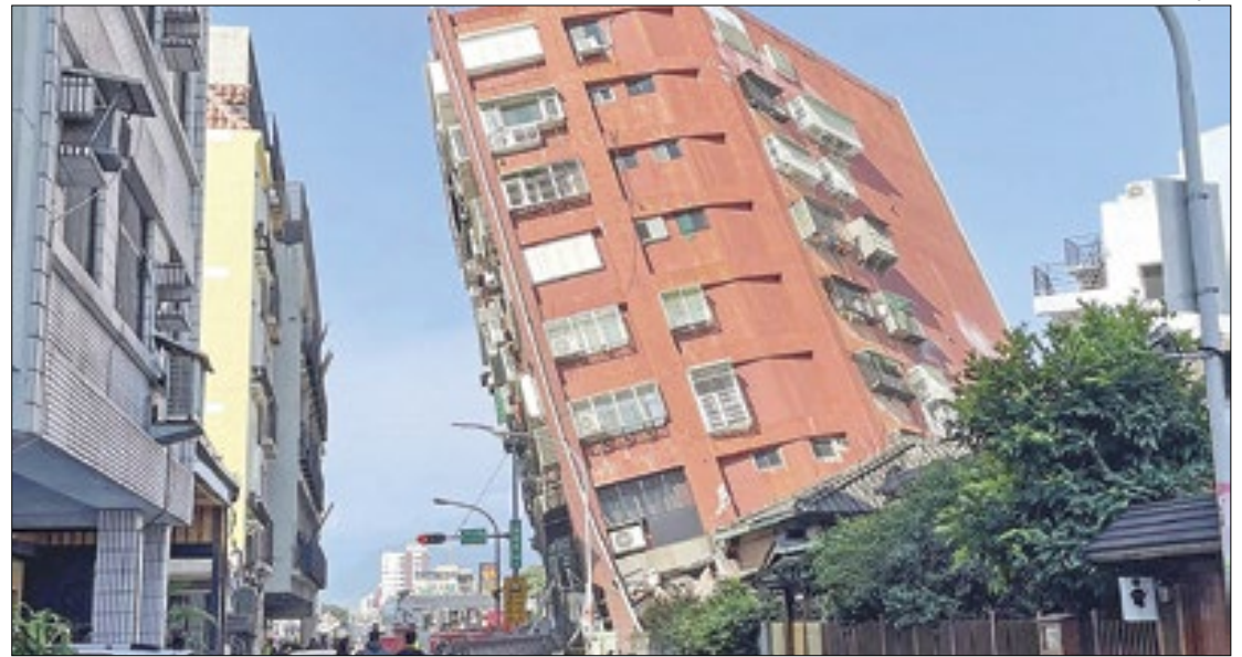
Tremores fizeram prédios desabarem e causaram deslizamentos
