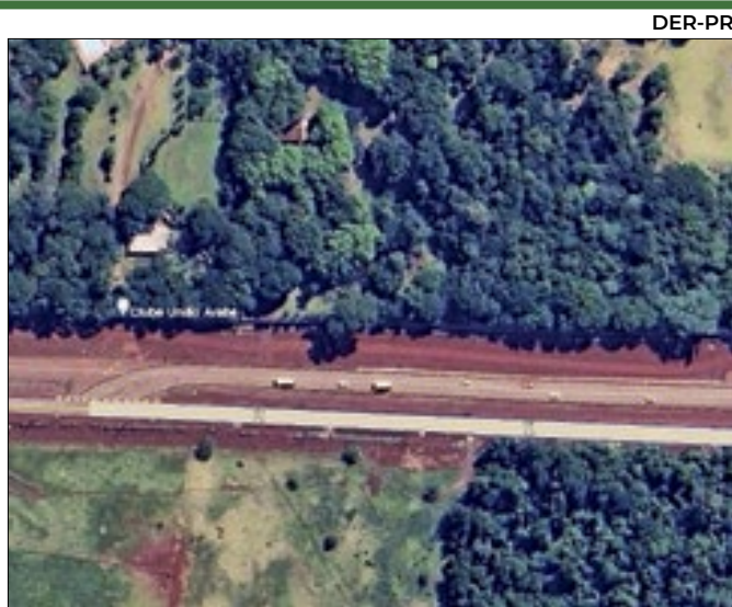
Duplicação e construção de passa-fauna
