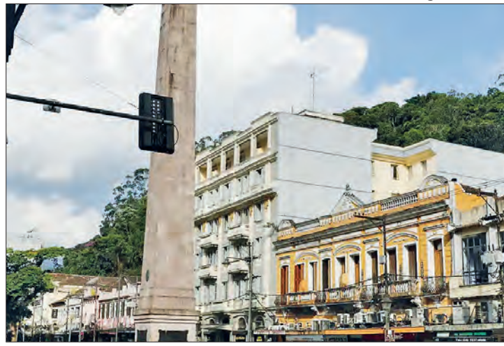
Defesa Civil evacuou Rua do Imperador no início da chuva
