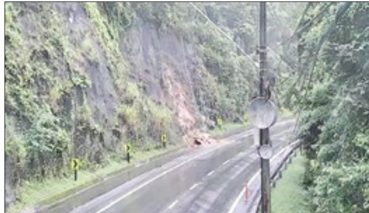
Após queda de barreira, Serra é interditada
