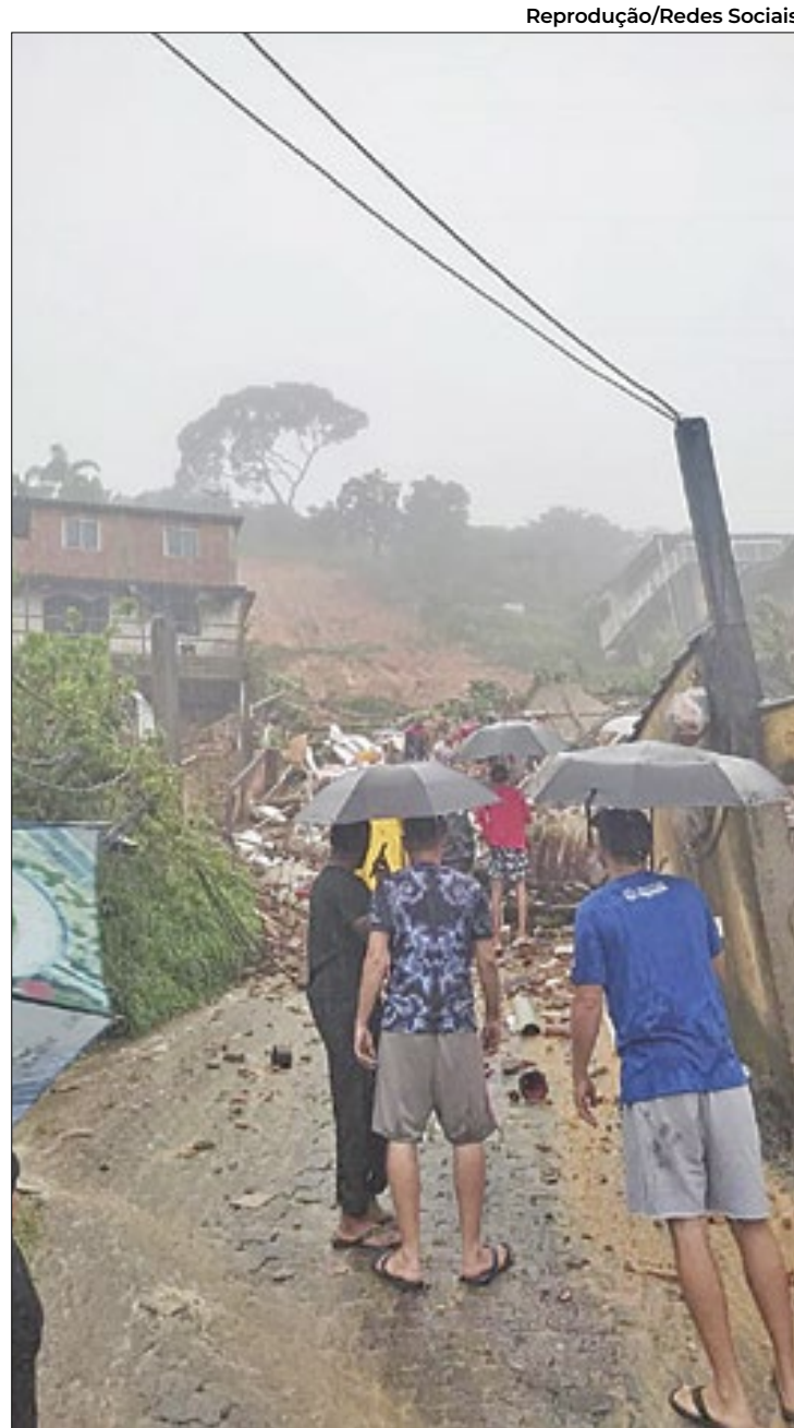
Desabamento de casas no Independência, em Petrópolis
