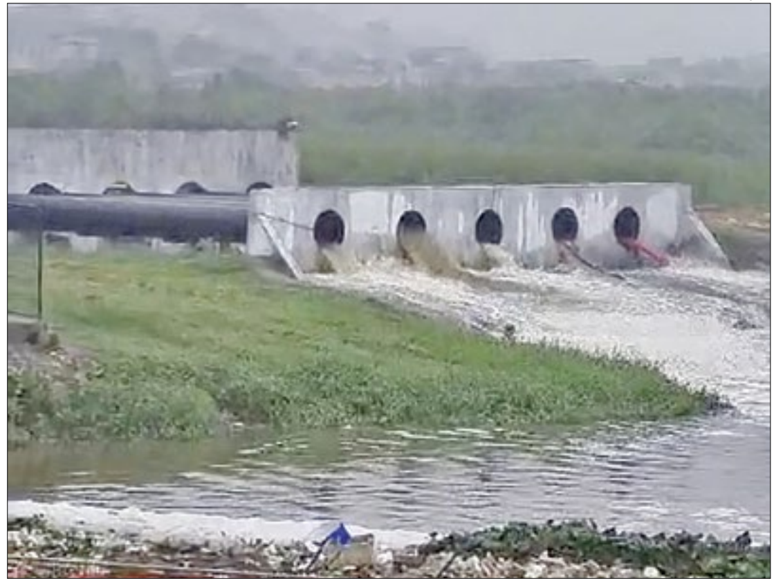
Instalação emergencial de bombas no Pôlder do Outeiro reduzem alagamentos na região
