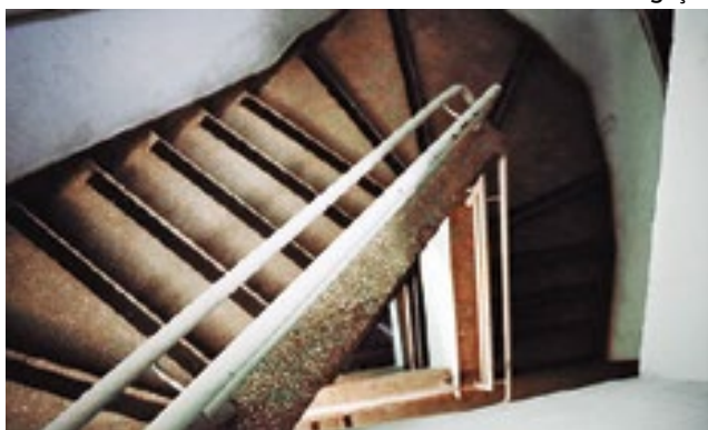
A escadaria do prédio onde o jovem Lô Borges conheceu Milton cantando e tocando violão para aproveitar a acústica privilegiada
