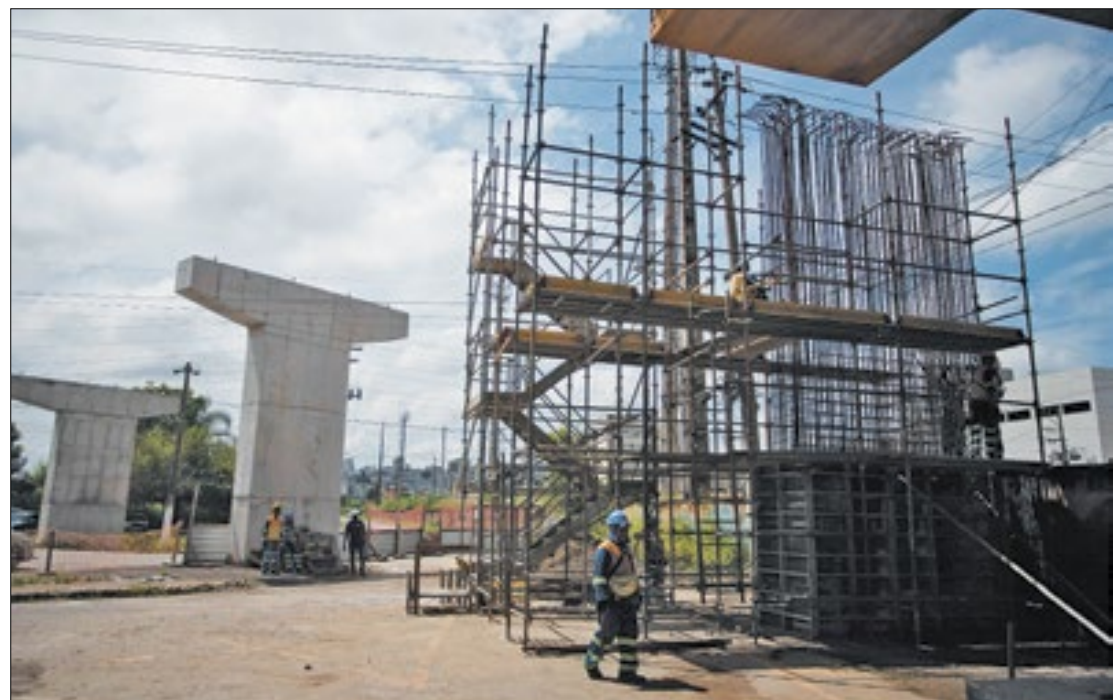
Construções fazem parte das obras que estão dentro do Plano de Mobilidade Urbana
