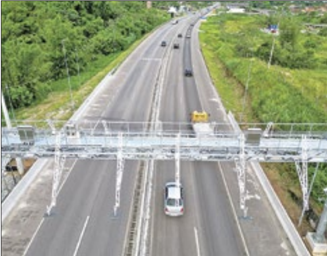
Tecnologia nos pórticos permite circulação fluida
