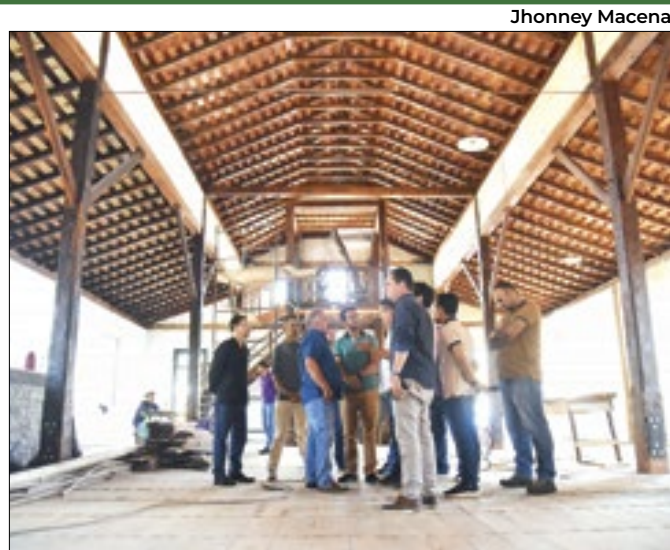
Prefeitura afirma que obras estão 70% concluídas
