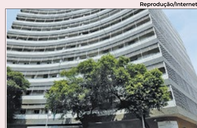
Leitos fechados e falta de insumos no INCA
