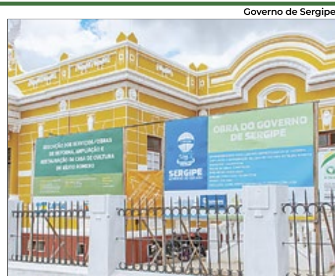
Prédio histórico passa por resgate cultural e preservação
