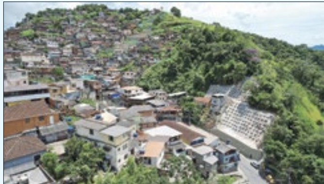
Rua 24 de Maio, comunidade afetada pela tragédia
