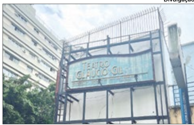
Equipamento será todo reformado e remodelado
