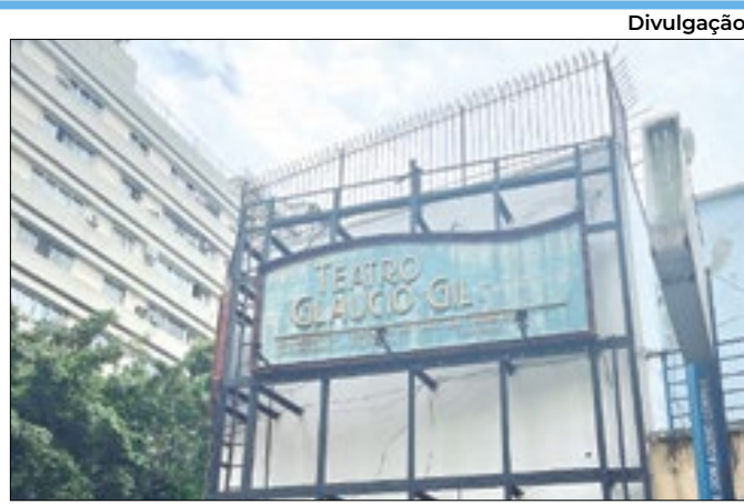
Equipamento será todo reformado e remodelado
