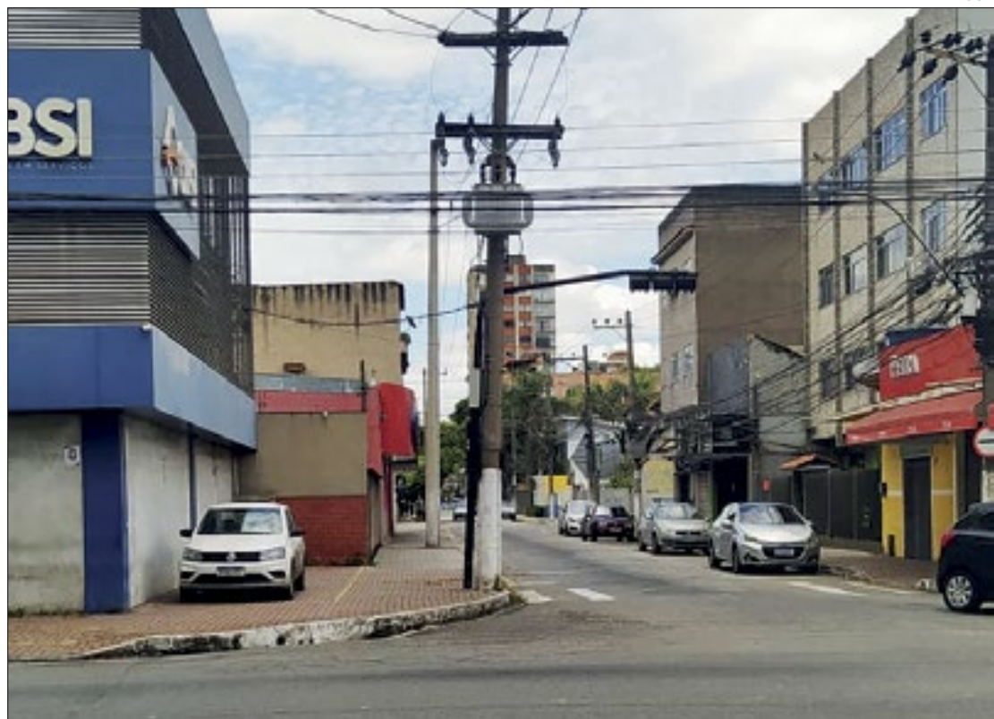
Moradores do bairro Aterrado, em Volta Redonda, temem queda de postes
