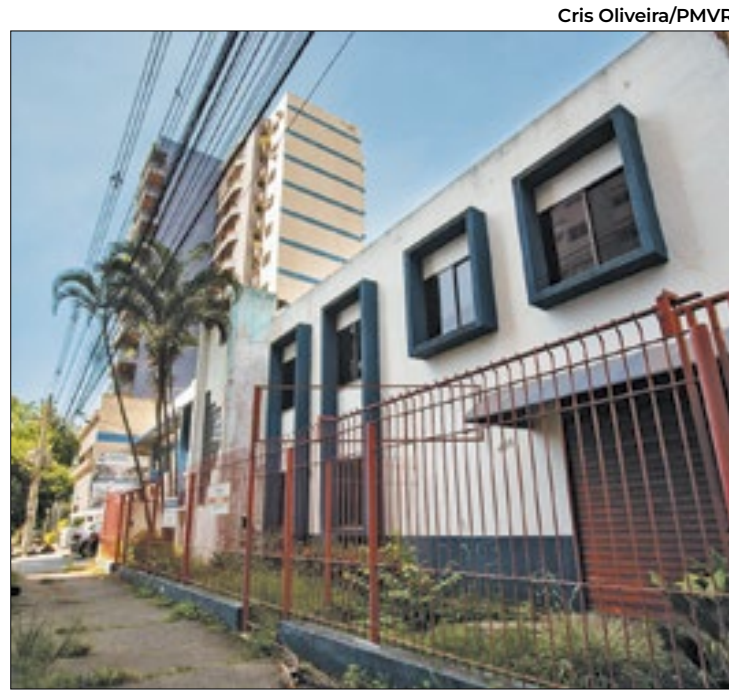
Imóvel está localizado na Rua Coroados, no Aterrado
