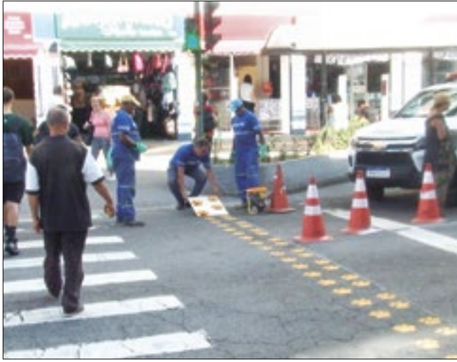
Faixa de pedestre é colocada na Rua Paulo Barbosa
