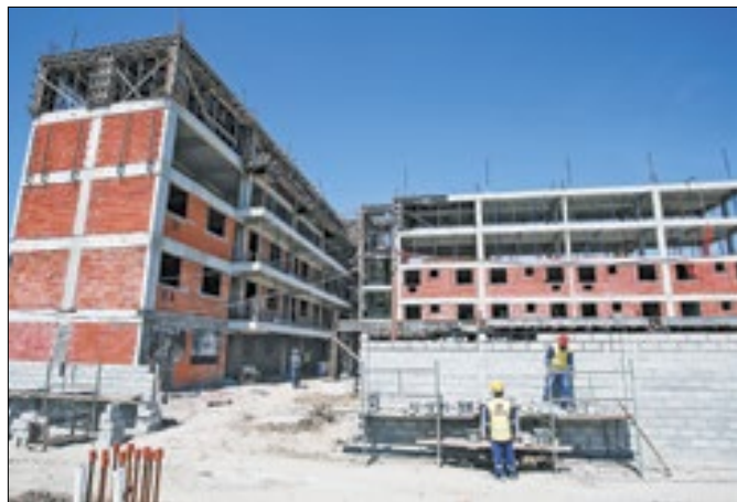
Obras estão na fase de acabamentos estruturais
