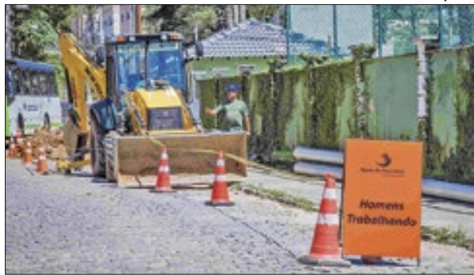
Águas da Imperatriz iniciou obras de extensão de rede
