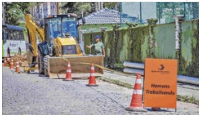
Águas da Imperatriz iniciou obras de extensão de rede
