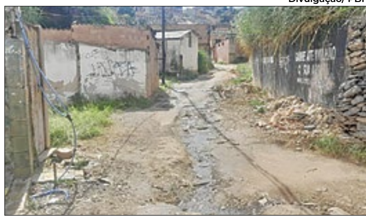
Obras de urbanização da Vila Apolônia foram retomadas
