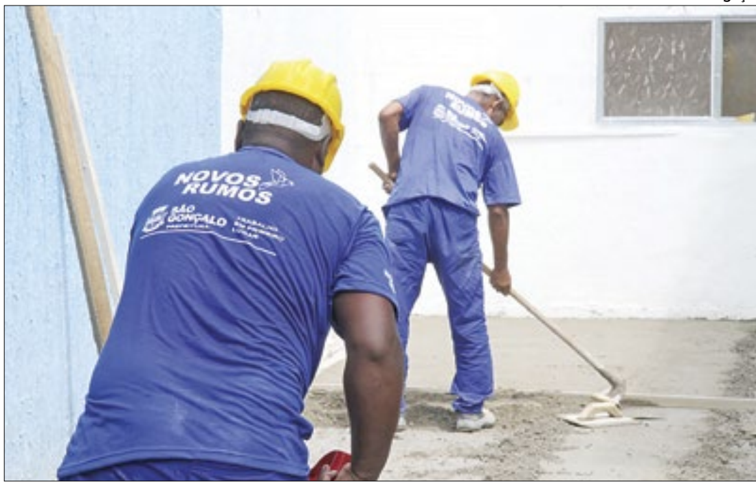
Obras na clínica do Barro Vermelho, em São Gonçalo, seguem em estágio avançado
