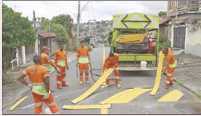
Diversas ruas do bairro receberam obras de infraestrutura
