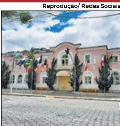
Intervenção ainda não tem prazo
