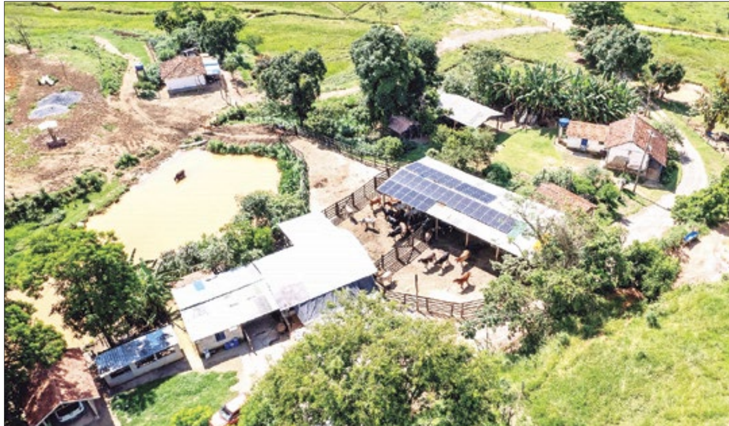
Próximo ao município de Resende placas solares têm capacidade de gerar uma média de 1.193 kW/h de energia por mês
