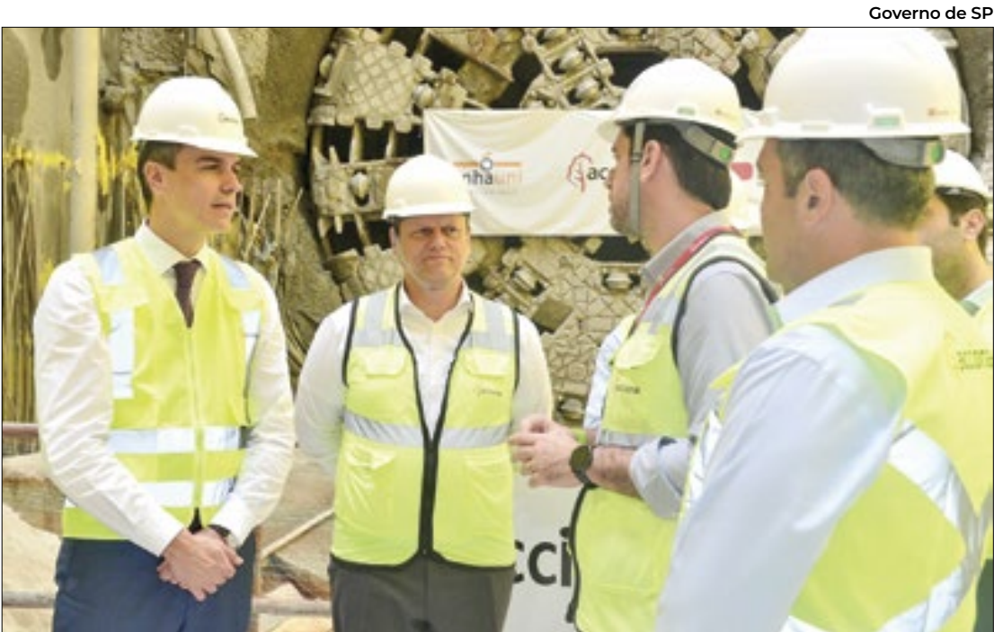
Visita às obras da nova linha de metrô de SP aconteceu nesta quinta-feira
