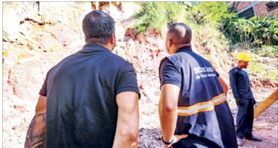
Secretários foram ao local para acompanhar início das obras
