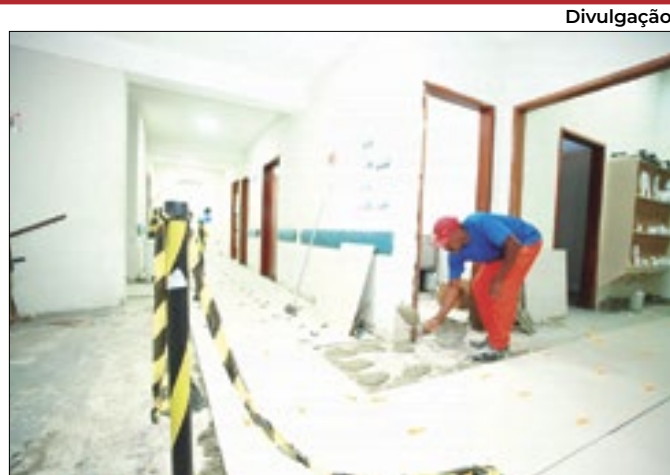
Obras no HGNI se encontram em estágio avançado
