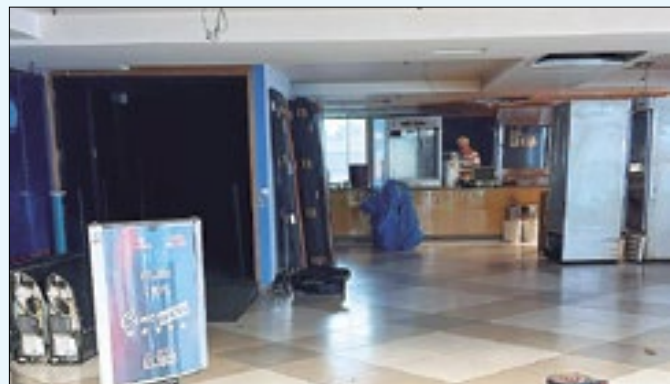
Paralisação deve-se pelas obras de expansão do local
