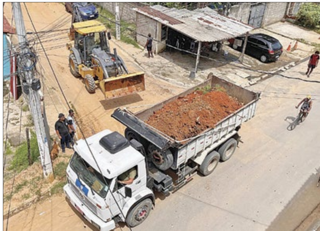
Trabalho na reconstrução das localidades afetadas pelas chuvas permanece em Japeri
