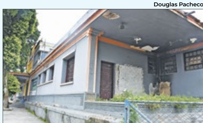
Espaço está recebendo melhorias estruturais
