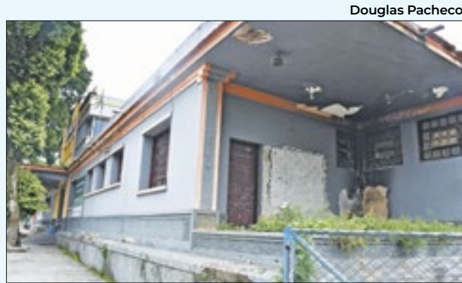
Espaço está recebendo melhorias estruturais
