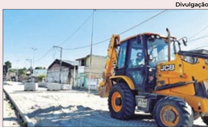
Obras no Calçadão da Avenida Carmem Carneiro
