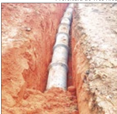
Obras de infraestrutura
