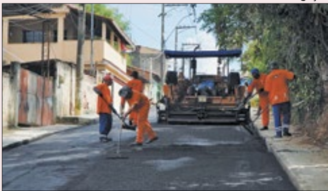
Seis ruas do bairro estão recebendo pavimentação
