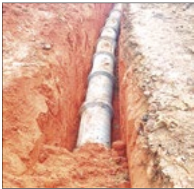
Obras de infraestrutura
