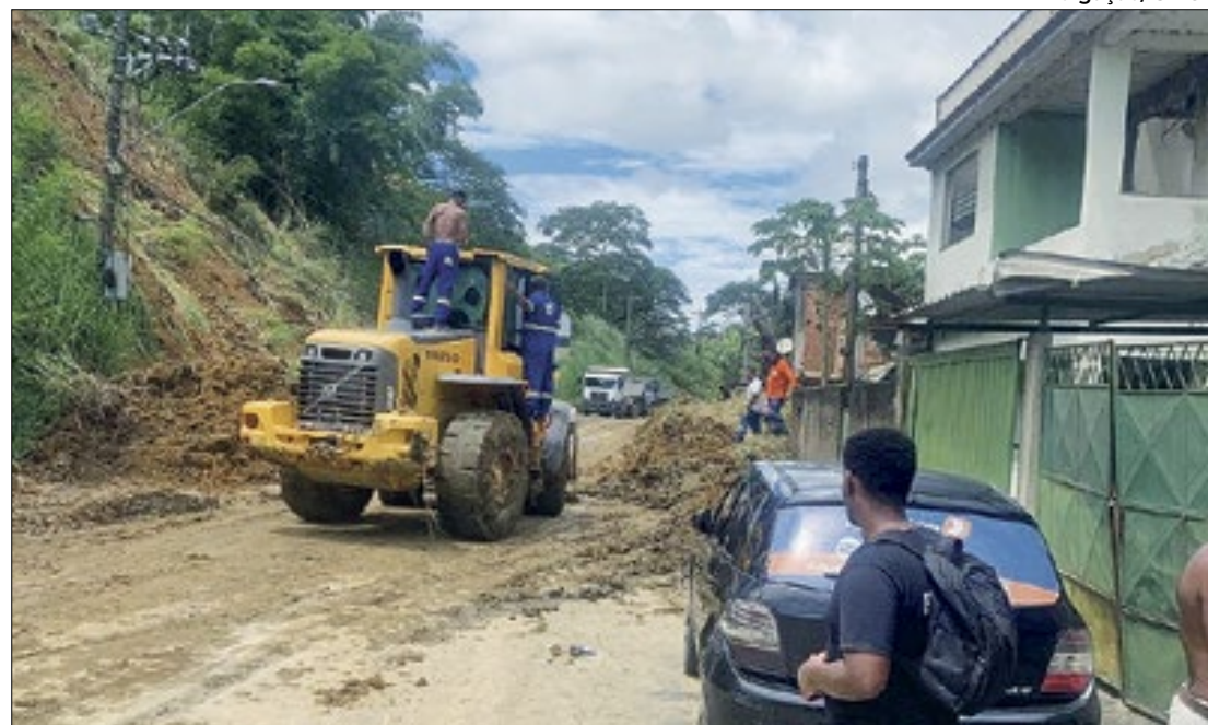
Estado já disponibilizou mais de 100 maquinários, como caminhões e retroescavadeiras
