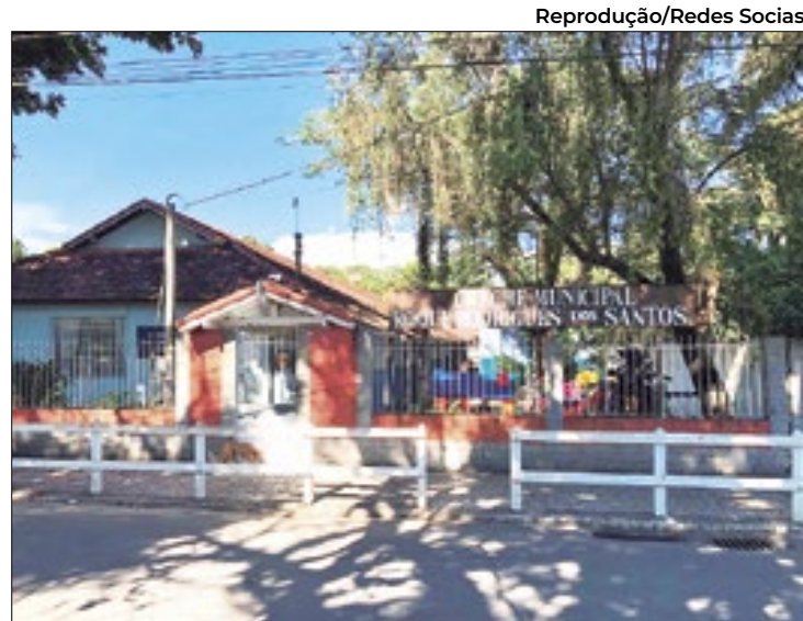
Creche Municipal Rodrigues dos Santos em Paraíba do Sul
