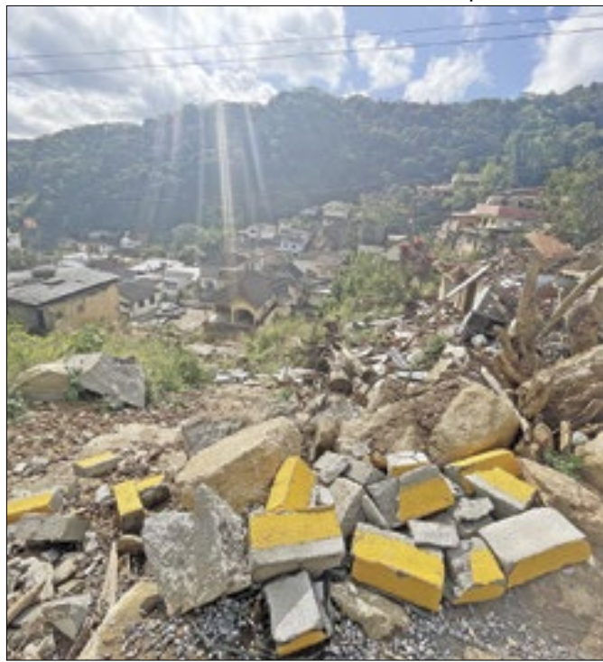
No Caxambu, o cenário de destroços da tragédia
