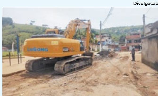
Obra facilita escoamento de água da chuva
