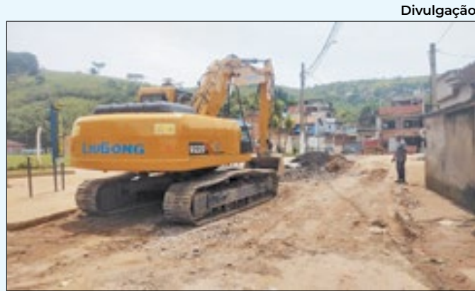
Obra facilita escoamento de água da chuva
