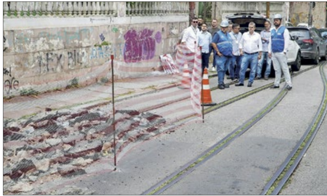
Secretário Washington Reis acompanha as obras
