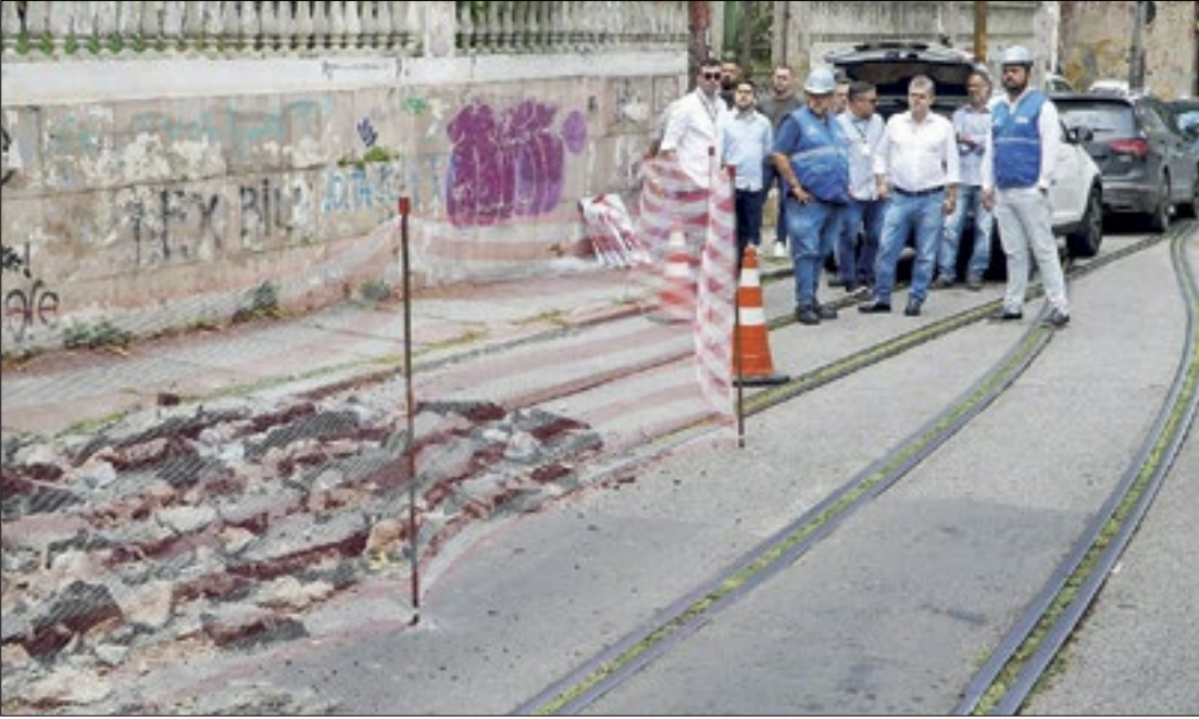
Secretário Washington Reis acompanha as obras
