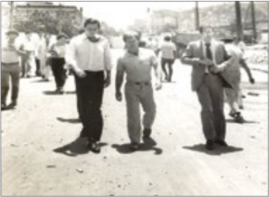
Nesta foto estão Marcelo Alencar, segundo prefeito nomeado pelo governador, em 1983, e o primeiro secretário de Turismo do Rio, Nestor Rocha, vistoriando as obras da passarela
