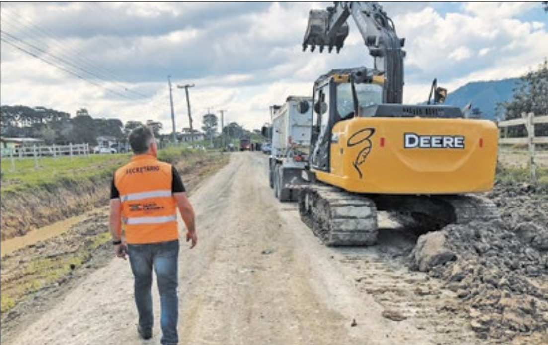
Estrada Boa: retomadas as obras na SC-370 entre Urubici e Rio Rufino
