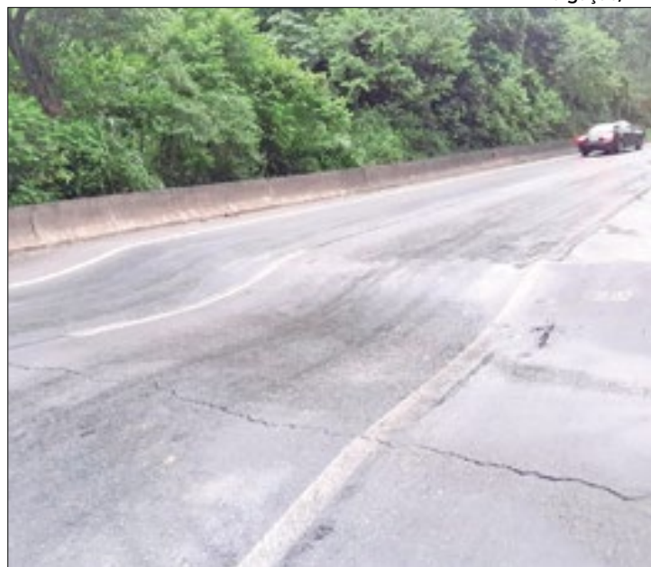
As obras são para corrigir uma angulação no km 228
