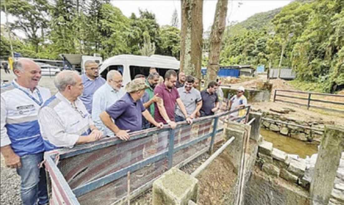
Governador Cláudio Castro acompanhou o andamento das obras do Túnel Extravisor
