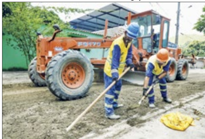
Nova Iguaçu e Queimados recebem pacote de obras
