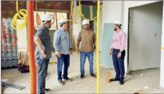
No HFM, a fundação, os pilares e a laje já foram concluídos
