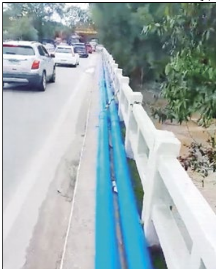
Tubos obrigam pedestres a passarem pela Rio-Santos
