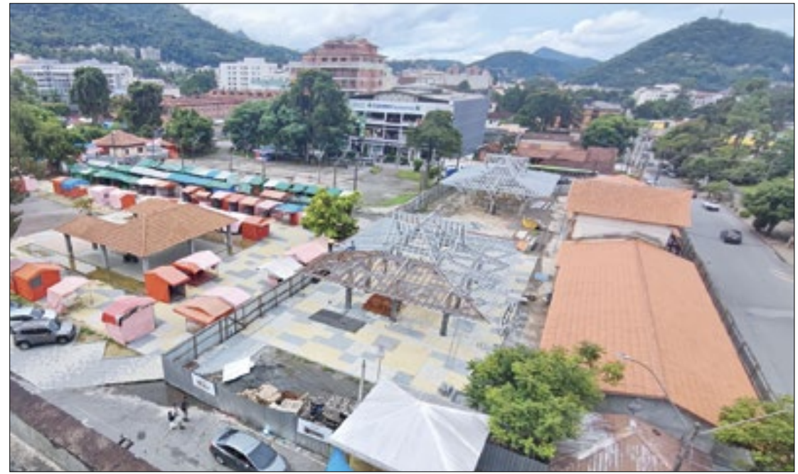
Obra na praça de alimentação está em andamento
