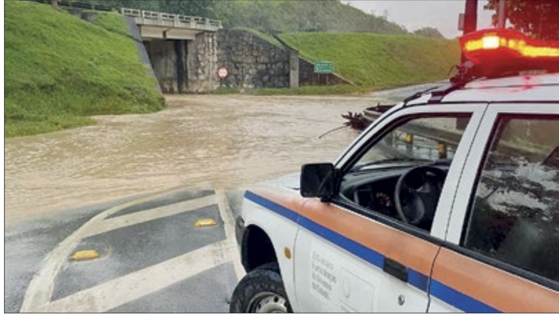
As chuvas torrenciais podem causar problemas como alagamentos e enxurradas
