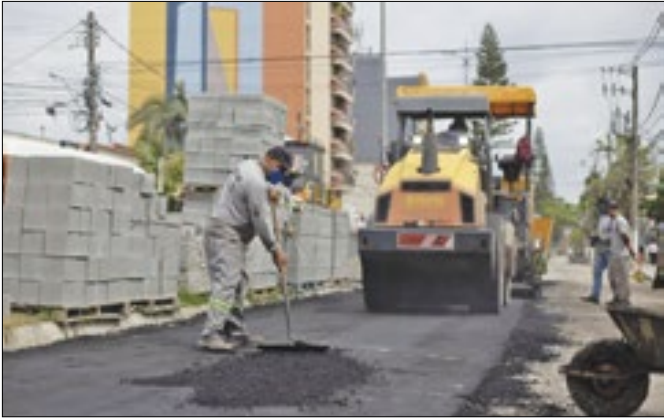
Asfalto é colocado à pressa para atenuar prejuízos
