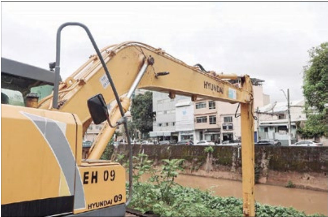
Rio Piraí receberá limpeza e desassoreamento
