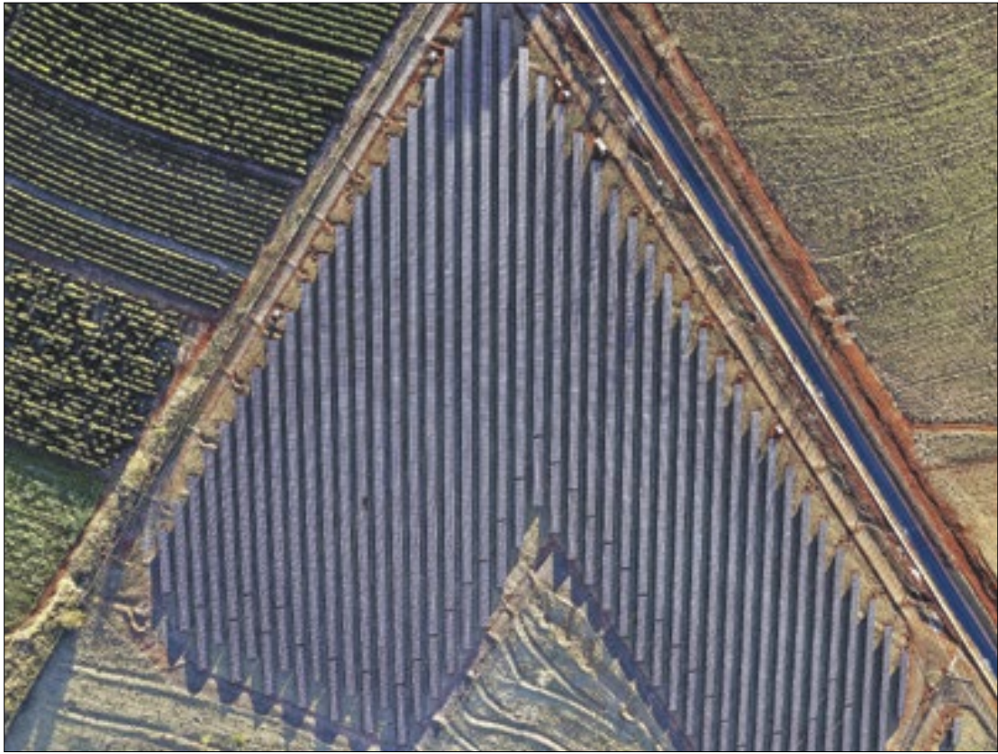
Vista aérea de usina solar com módulos fotovoltaicos feitos pela BYD em área rural de SP
