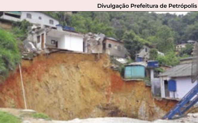
Deslizamento na BR-040, que liga o Rio de Janeiro a Juiz de fora, destruiu uma casa e abriu uma cratera às margens da pista.
