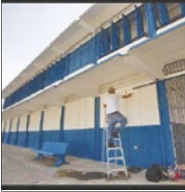
Obras no Capd II
