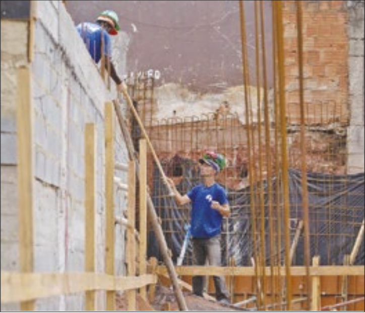
Equipes responsáveis pela obra de Volta Redonda já iniciaram a fundação do local
