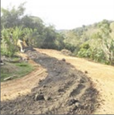
Estradas serão niveladas
